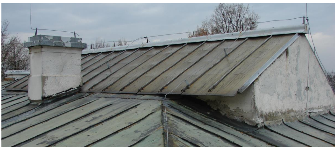
Widok świetlika od strony południowo-wschodniej
