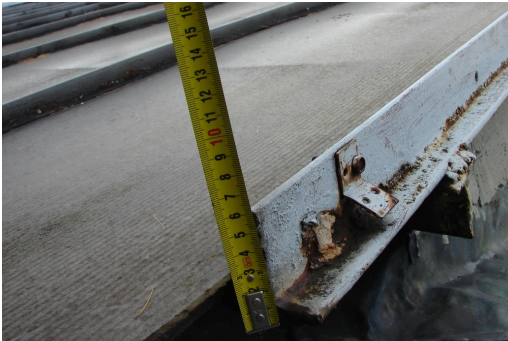
Główny profil nośny połaci świetlika 1/2IPE120
